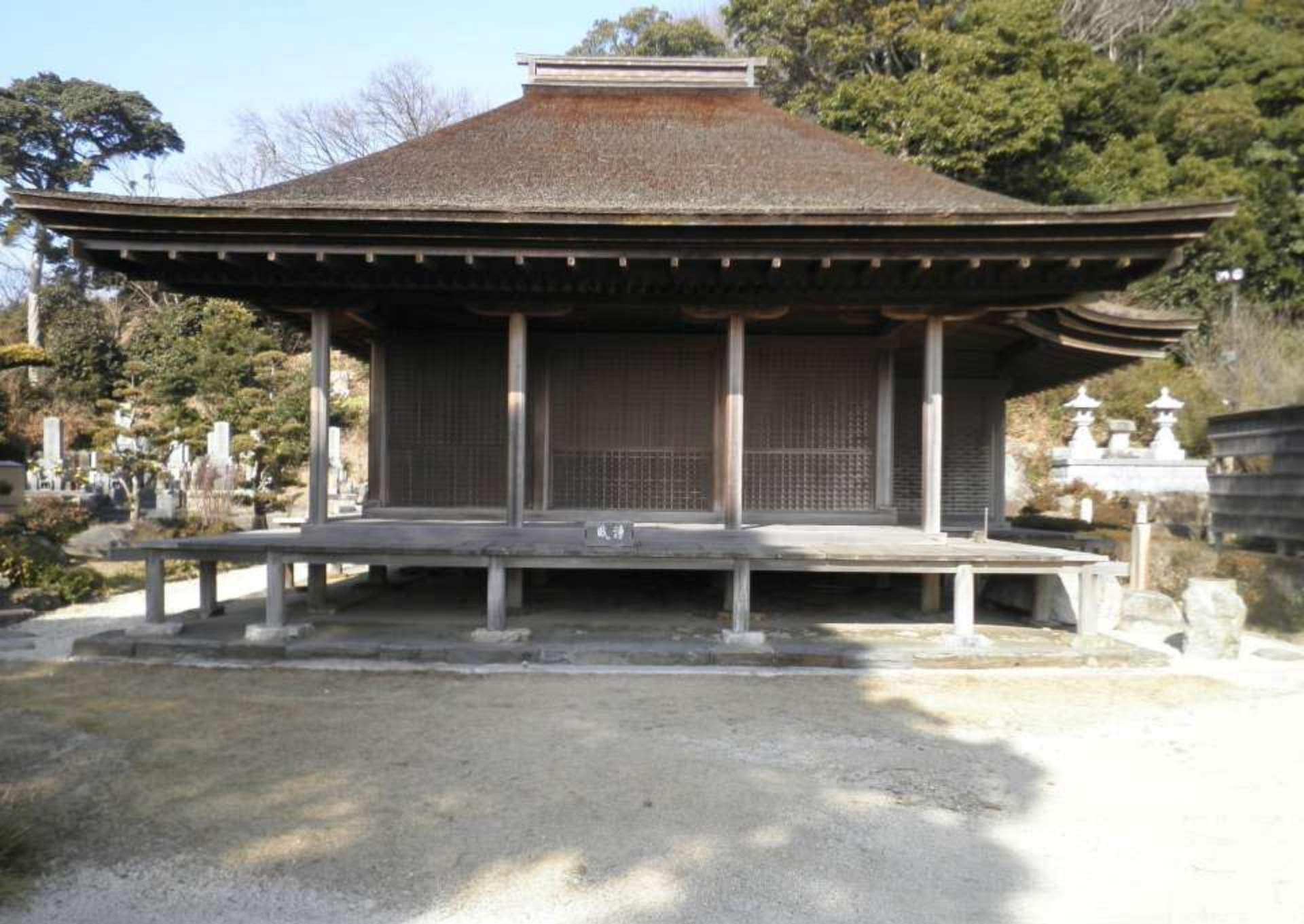
金蓮寺弥陀堂:国宝 昭和29年解体修理で檜皮葺に復元し 翌年国宝指定された・・「看板一枚の国宝もあるんだ」と、感心する
